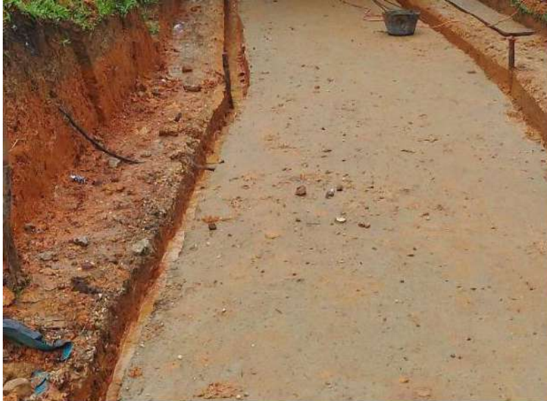
Avance de Obra Chorrera
